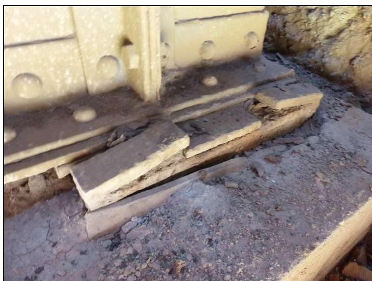
Foto č. 12 Konstrukce K 13 Pevné ložisko vlevo – zleva utržené obě zarážky
