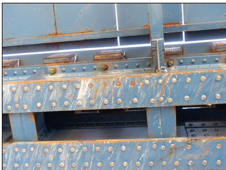
Foto č. 11 Konstrukce K 13 Vrypy od vozidel v dolní pásnici levého vnějšího hlavního nosníku, usmýknuté hlavy 4 nýtů + naražená pásnice
