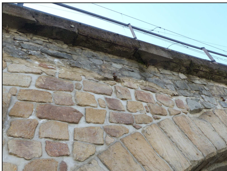
Foto č. 4 Konstrukce K 06 Čelní zedř vpravo na začátku Boulení zdiva, popraskané spárování
