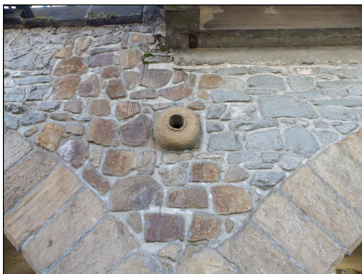
Foto č. 16 Pilíř P 12 vpravo Z čela nad pilířem svislá trhlina v čelní zdi
