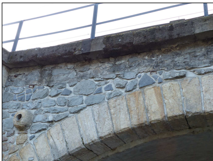
Foto č. 3 Konstrukce K 05 Čelní zed' vpravo na začátku Boulení zdiva, popraskané spárování
