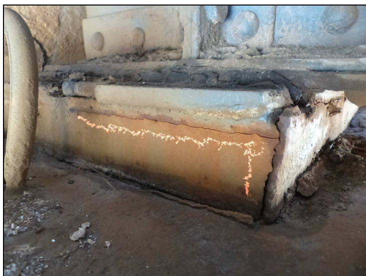
Foto č. 8 Konstrukce K 11 Pevné ložisko vlevo – prasklé svary v krycí pásnici zleva
