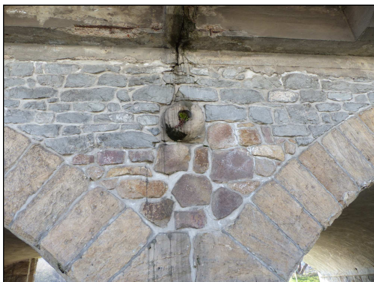
Foto č. 17 Pilíř P 14 vpravo Z čela nad pilířem svislá trhlina v čelní zdi
