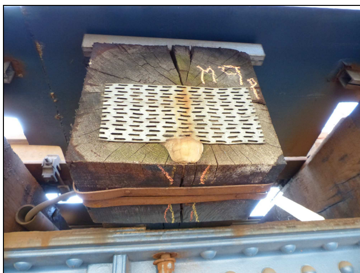
Foto č. 18 Konstrukce K 09 Mostnice č. 9 zprava Výskyt dřevokazné houby
