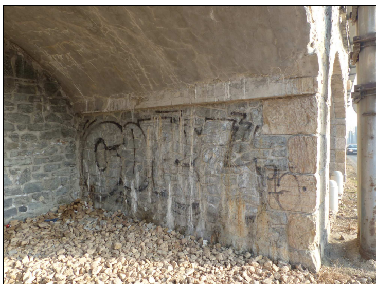
Foto č. 6 Konstrukce K 08 Průsaky s výluhy pojiva
