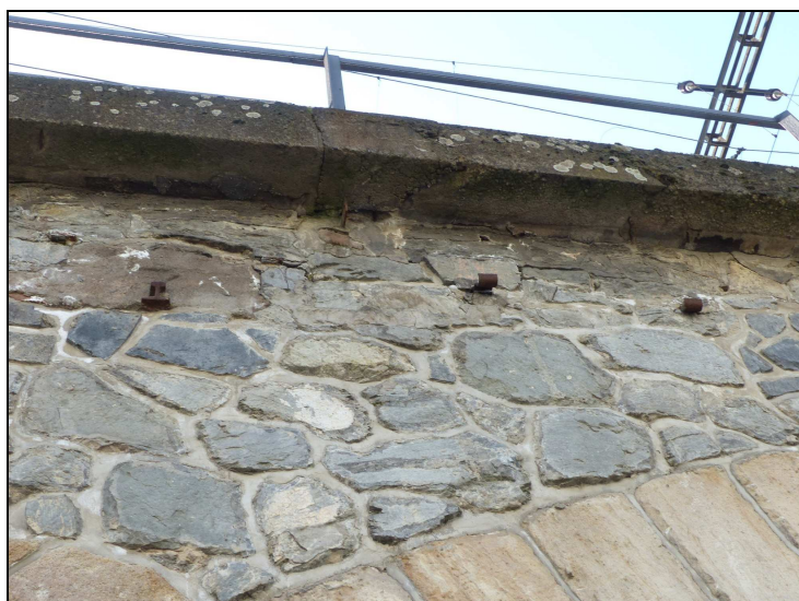
Foto č. 5 Konstrukce K 07 Čelní zedř vpravo na začátku Boulení zdiva, popraskané spárování
