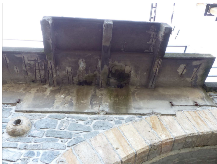
Foto č. 1 Konstrukce K 03 Chodníková konzola vpravo průsaky, degradace betonu, korozní oslabení odhalené výztuže
